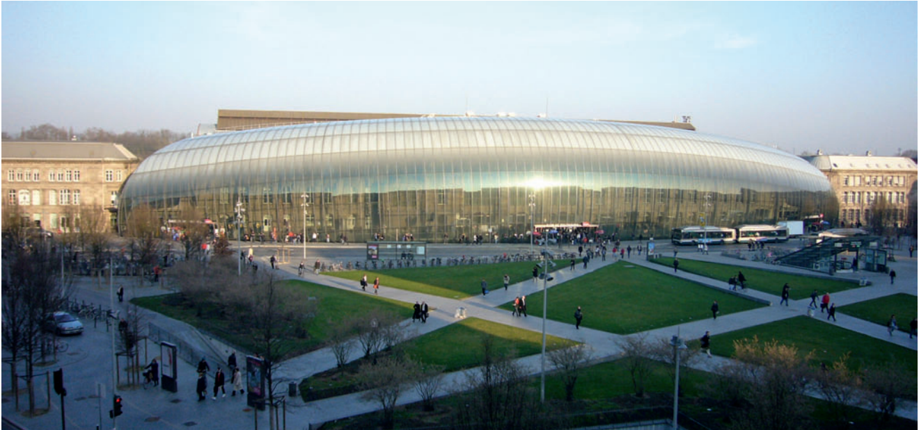
1 Bahnhof mit vorgebauter Glasfront
