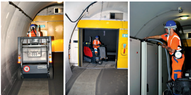
7 Reinigungsarbeiten in einem Querschlag des Lötschberg-Basistunnels
