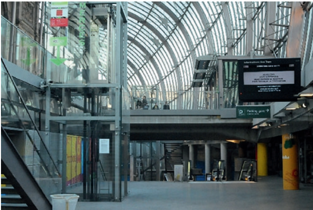
2 Zugang zur unterirdischen Haltestelle aus der Halle und Eintrag von Nebel (linkes Bild) sowie eingebrachte Feuchtigkeit zur Bindung bahnstaubbedingter Partikel
